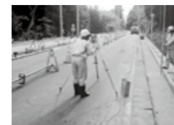
道路拡幅工事の段階確認の様子 新潟県 新発田地域振興局 地域整備部 道路課 松野 由希さん▶P.19
